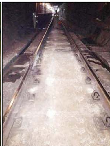
(b) 地铁道床加固后
