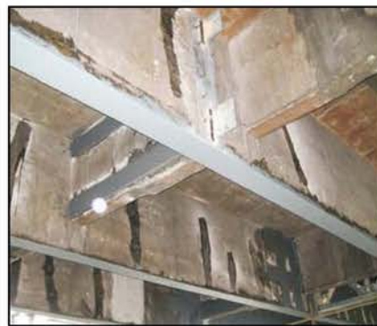
桥梁裂缝粘结补强
