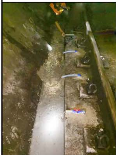
(a) 地铁道床加固前
