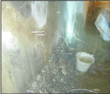
施工缝渗漏治理
